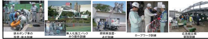
排水ポンプ車の設置・排水訓練 無人化施工バックホウ操作訓練 照明車設置・点検訓練 ロープワーク訓練 応急結立構築設置訓練
