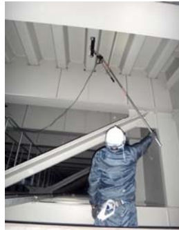
5m程度までは、箱桁内から調査可能
