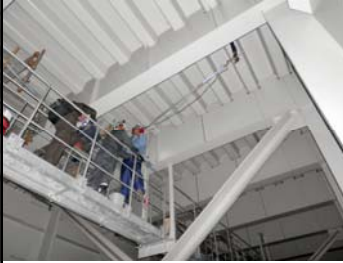
桁の高さが高い場合でも、検査路から調査可能
