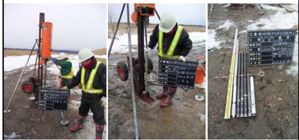
全景 ロッド一本目 観測装置・ロッド式 設置作業の状況
