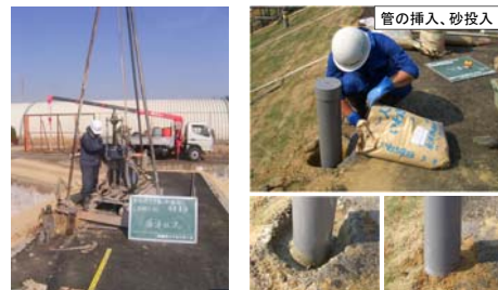
ボーリングマシンによる削孔
