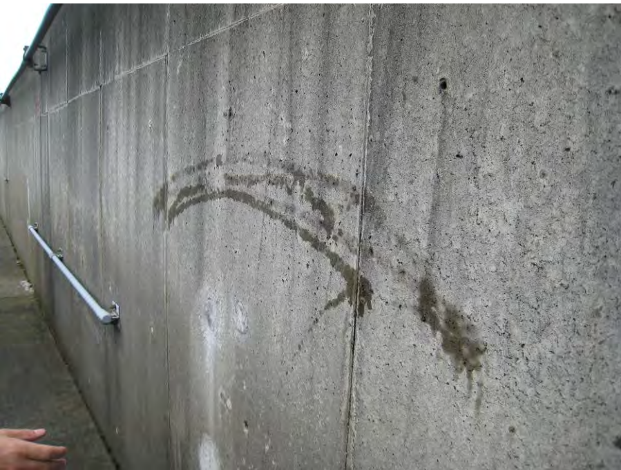
粗なコンクリート 瞬時に水を吸い、垂れない
