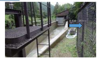
水槽兼沈砂池(排砂時)
