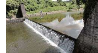
貯砂ダム全景(水位差約1.6m確保可能)
