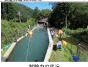
試験中の状況
