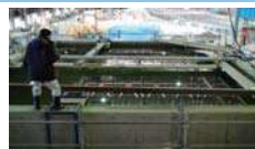
②水槽を満水とし、排砂管をクレーンで吊り下げ
