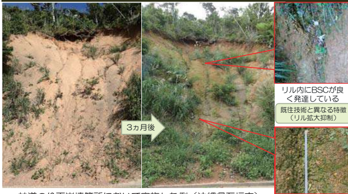
林道のり面崩壊箇所において実施した例（沖縄県石垣市）
