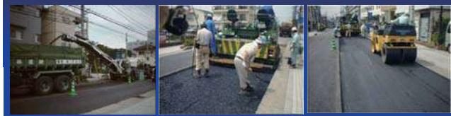
→ 【ガラスグリッドの敷設】 → 【タックコート(付着抑制型)】 → 【SMA(13)の舗設】
