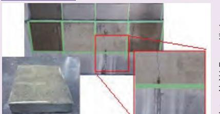
コンクリート構造物の耐久性向上・長寿命化を目的とした表面被覆材で、従来品同等の遮蔽性、ひび割れ追従性、防食性、施工性を有する上に、透明であるため、被覆後にも目視点検が可能な技術。
