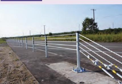
高いじん性を有するワイヤロープと、比較的強度が弱い支柱により構成され重大事故を大幅に減らすことが期待できる防護柵。従来の分離施設よりも必要な用地幅が小さいため、導入コストの縮減が可能。緊急時には部分的に開放区間を設け、反対車線を通行させる交通処理も可能。
