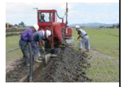
トレンチ掘削の例
