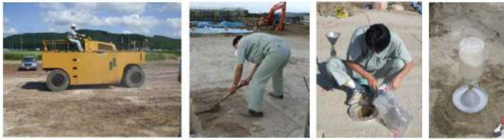
盛土転圧 表面均し 掘削 注砂
