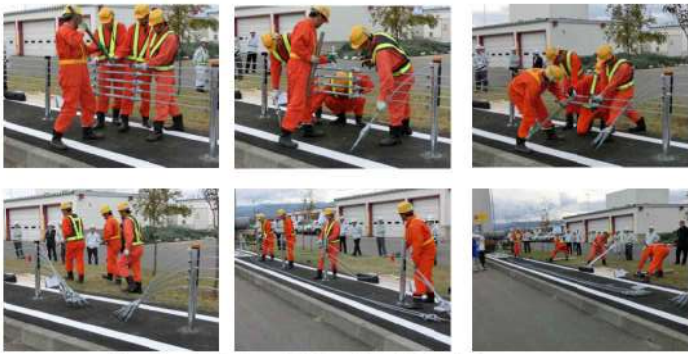
約7分で取り外し、開放区間の設置を完了！
