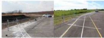
衝突後の防護柵の破損状況(2016年3月, 8月)
