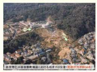
宅地造成盛土崩壊(1995/1月)
