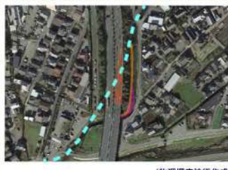
九州自動車道熊本地震時盛土崩壊(2016/4月)
