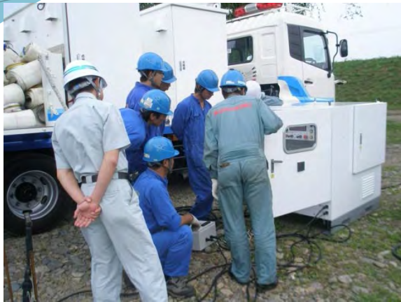
操作盤接続作業
