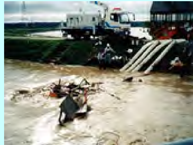
排水ポンプ車による排水作業 (出典：国土交通省北海道開発局HP)
