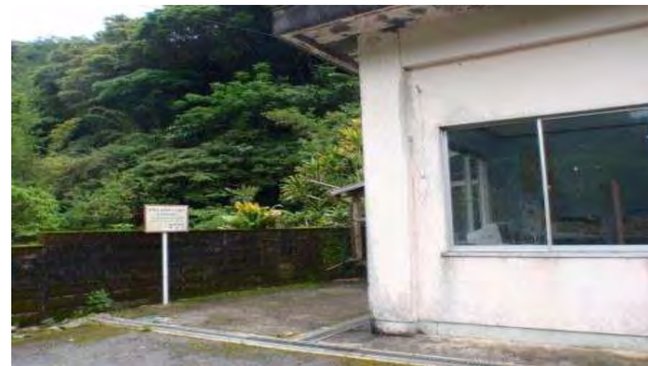
石原集落の避難場所: 急傾斜地崩壊危険箇所
