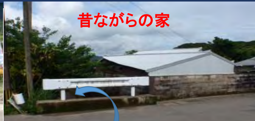
③②の橋の下流川(右の家は天井ぐらいまで浸水)
