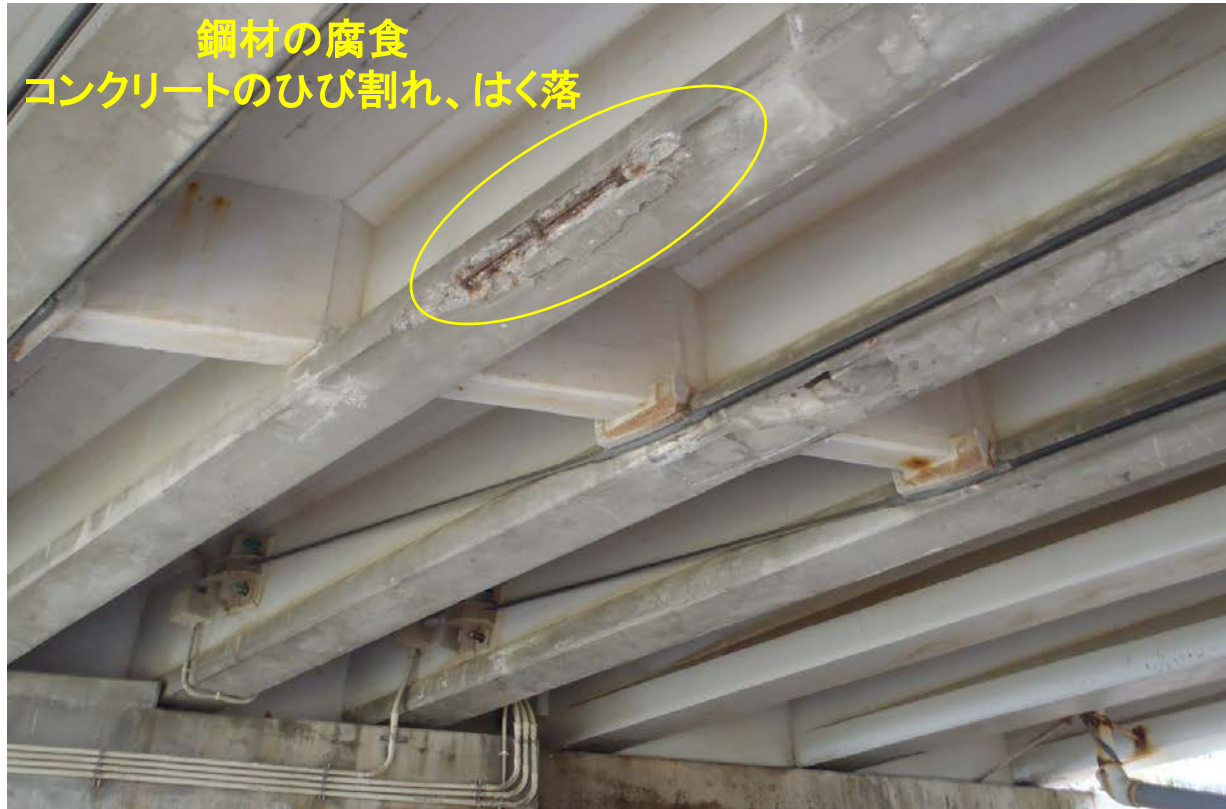
塩害地域の橋梁の例
