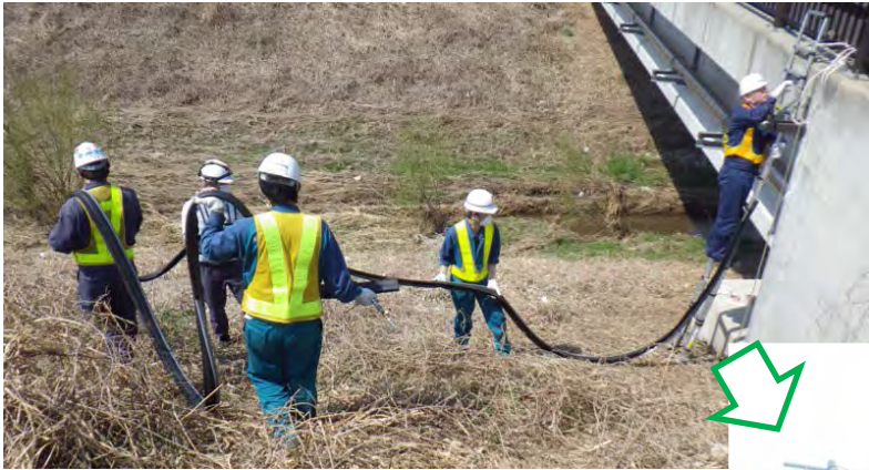
真空引きした後、 先導ワイヤに接続
