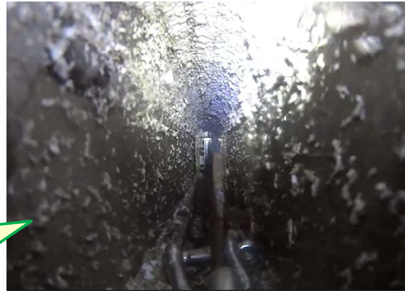
孔の拡大後の孔内部
