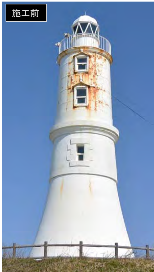
チタン箔シート貼付施工前外観
