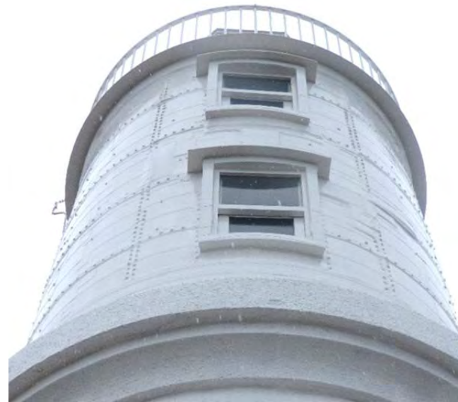
チタン箔シート貼付施工後近影
