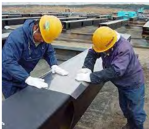
チタン箔シート貼付作業状況
