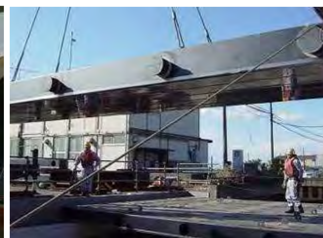
橋梁架設状況
