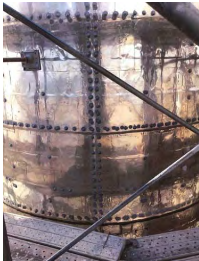
チタン箔シート施工時(塗装前)
