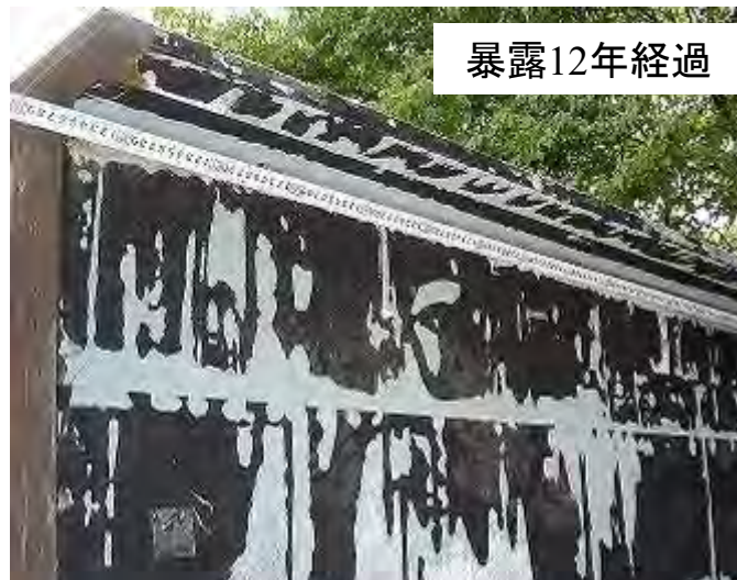
チタン箔シート除去後の状況
