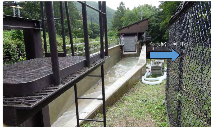
水槽兼沈砂池(排砂時)
