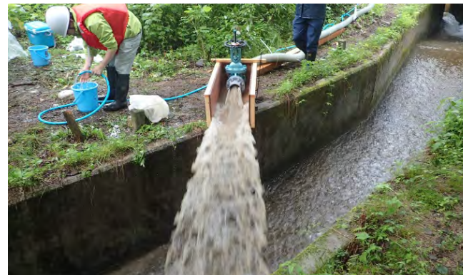
試験中の状況(吐口部)
