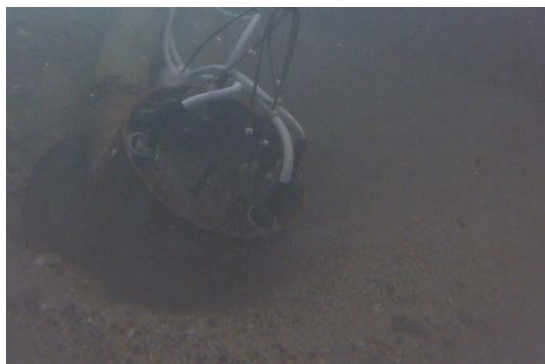
吸引部の土砂吸引の状況(水中)
