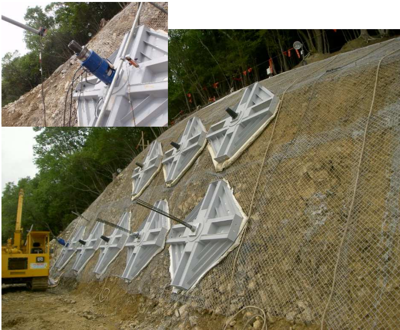
施工時に設置
