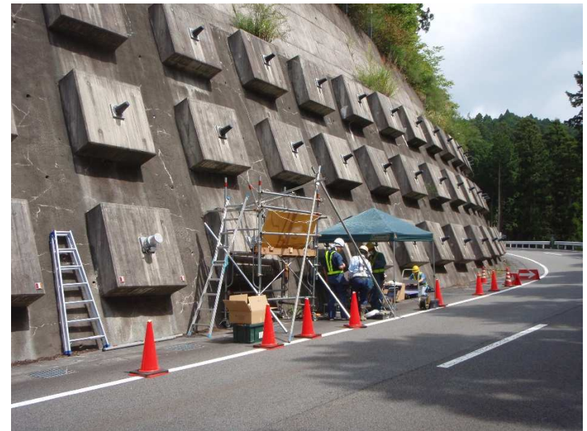
施工後に設置
