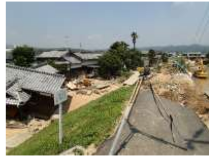
2018年岡山県倉敷市真備町の被害
