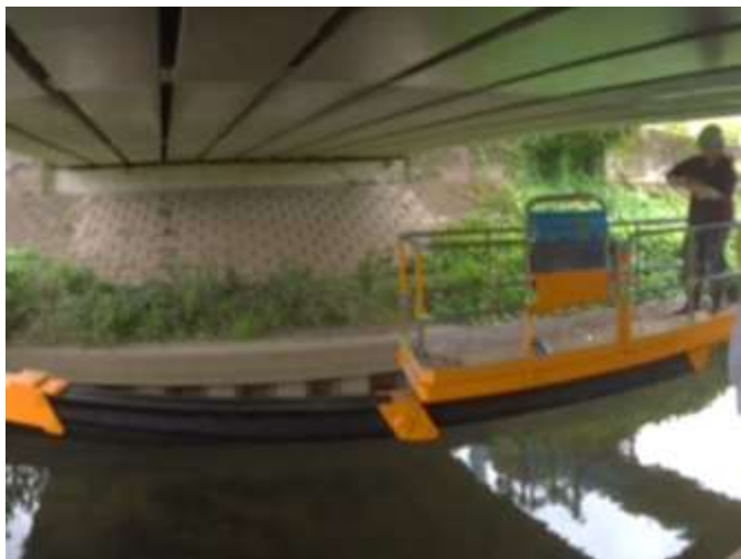
施工状況(2017年9月)
