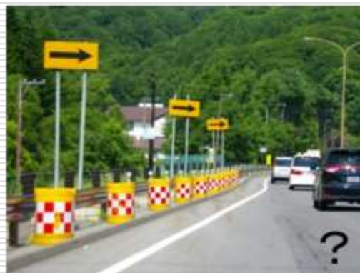
車線減少箇所でガードケーブルの前に視線誘導施設を設置した結果、その前にガードレールとクッションドラムを設置している事例（路肩直近に視線誘導施設を設置したことによる負の連鎖）
