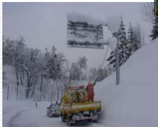
▲ F型標識背面の除雪作業
