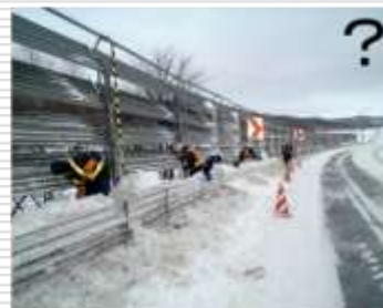
毎年のように発生する防雪柵の除雪 防護柵によって雪堤がある区間での視程障害
