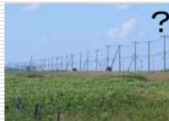
乱立する道路の柱類
