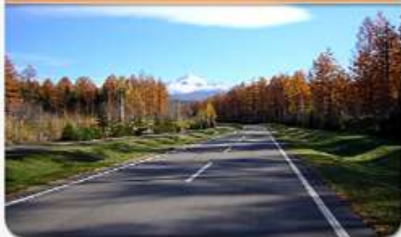
電線電柱・無電柱化
