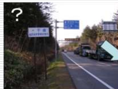
F型柱に情報板・2本の案内標識・管理区分標識を集約化することで、景観が保全された事例
