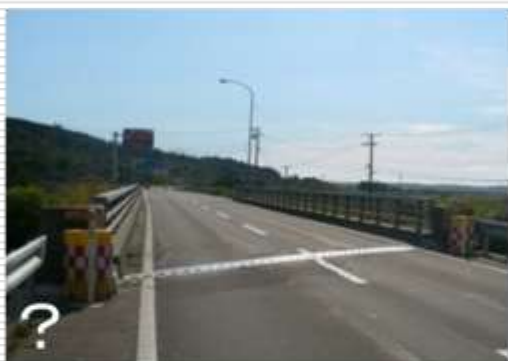
橋梁の親柱に反射板・視線誘導標・クッションドラムが連鎖的に整備されている事例
