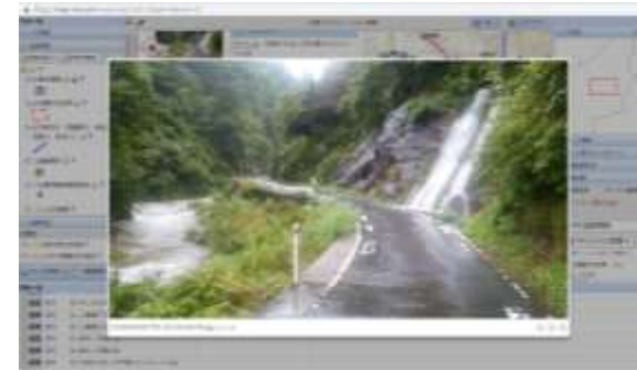
山肌からの出水状況(試験運用中に現地で 撮影されたもの)
