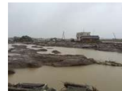
2015年関東・東北豪雨での常総市での被害
