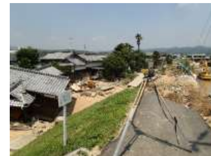
2018年岡山県倉敷市真備町の被害
