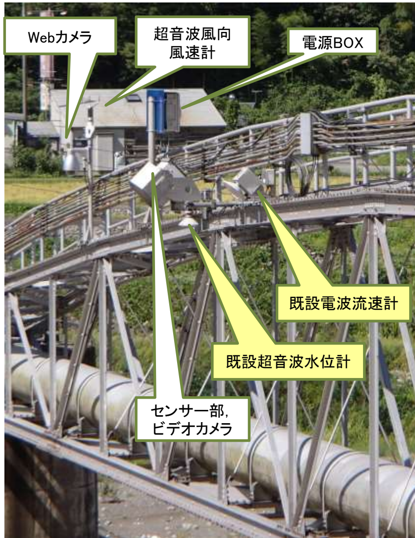
右岸(局舎近く)から撮影
