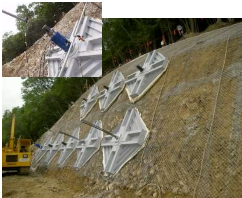
施工時に設置
