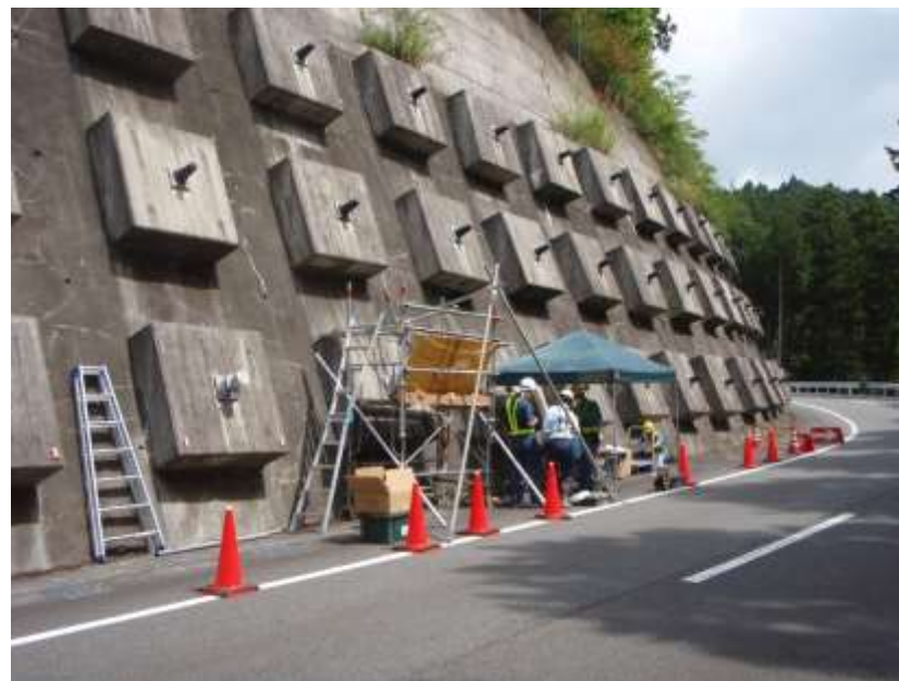
施工後に設置
