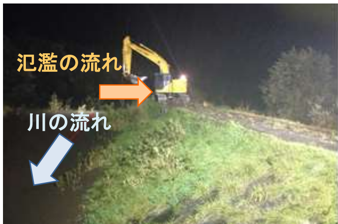
バックホウによる早期着手 (決壊発生から3時間後)
