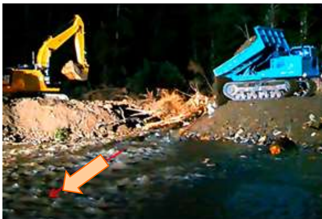
不整地運搬車の活用
