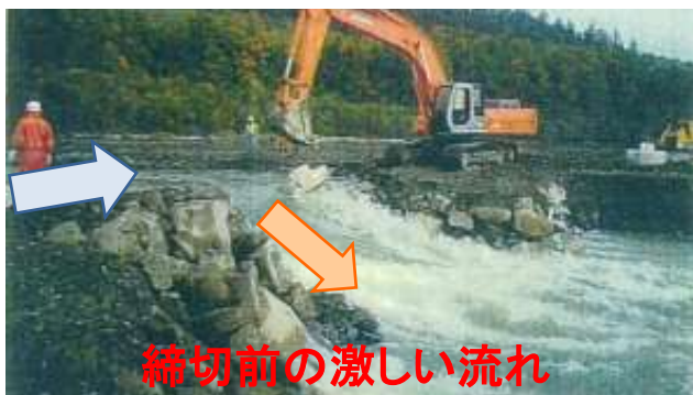
バックホウによる早期着手 (決壊発生から3時間後)
