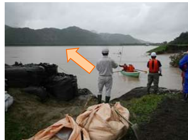
決壊口内の深掘れ箇所の計測
