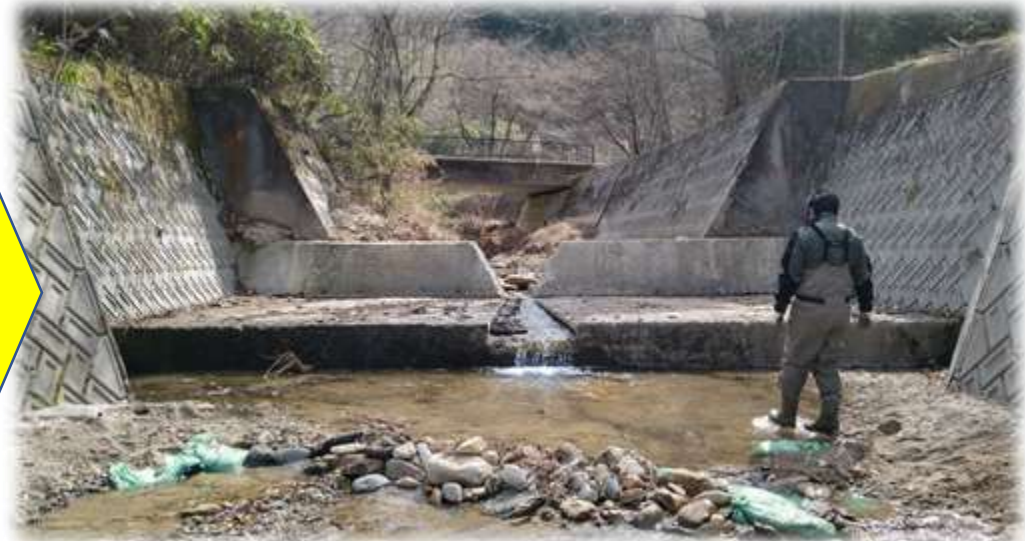
切欠き魚道 完成
