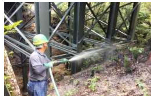
工事荒廃箇所への適用例
