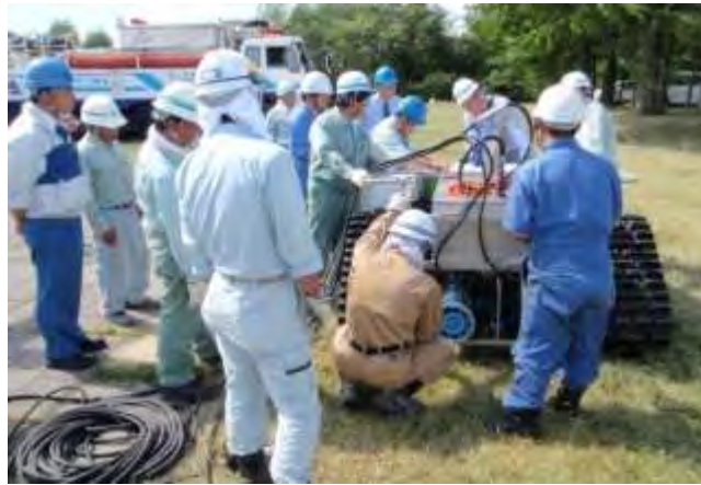
排水ポンプ搭載作業
