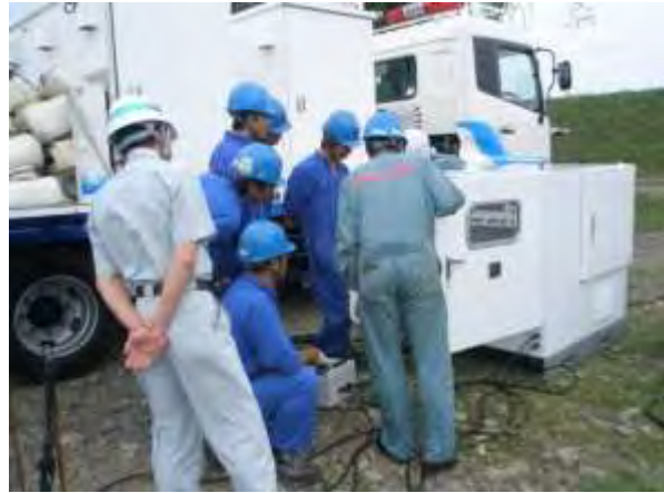
操作盤接続作業
