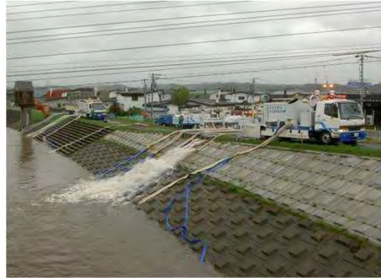
排水ポンプ車による排水作業 (出典：国土交通省北海道開発局)
