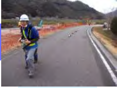
牽引式電気探査
