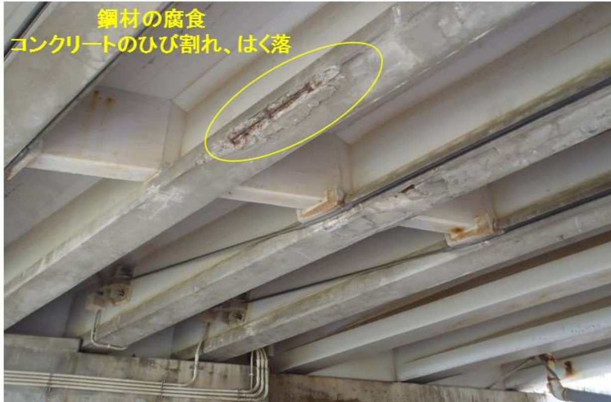
塩害地域の橋梁の例
