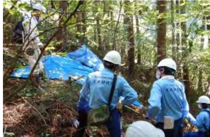
林地内に生じた滑落崖の確認
