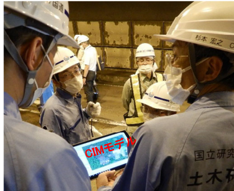
地すべりとトンネル位置の確認
