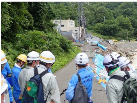
緊急的な現地調査
