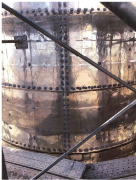
チタン箔シート施工時（塗装前）
