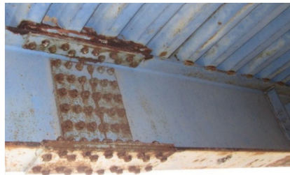
継手部（高力ボルトまわり）
