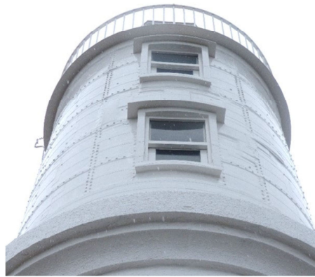
チタン箔シート貼付施工後近影
