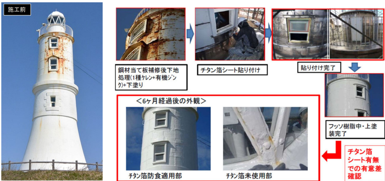
チタン箔シート貼付施工前外観
