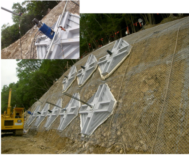
施工時に設置
