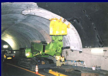
①施工写真
