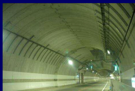
②完成写真
