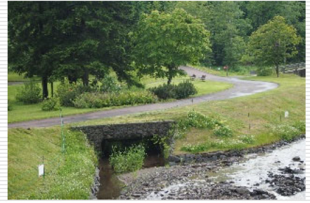
⑤小橋梁の架設位置
