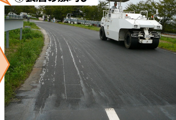
④表層の敷均し
