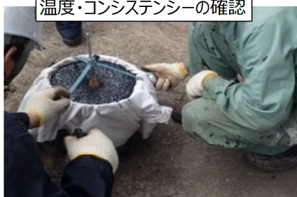
温度・コンシステンシーの確認
