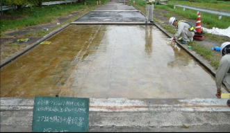
樹脂防水材料施工状況
