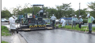
樹脂防水材料施工状況
