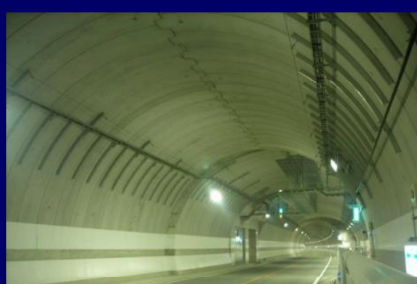
②完成写真
