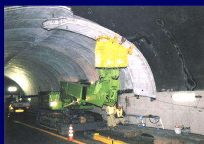
①施工写真
