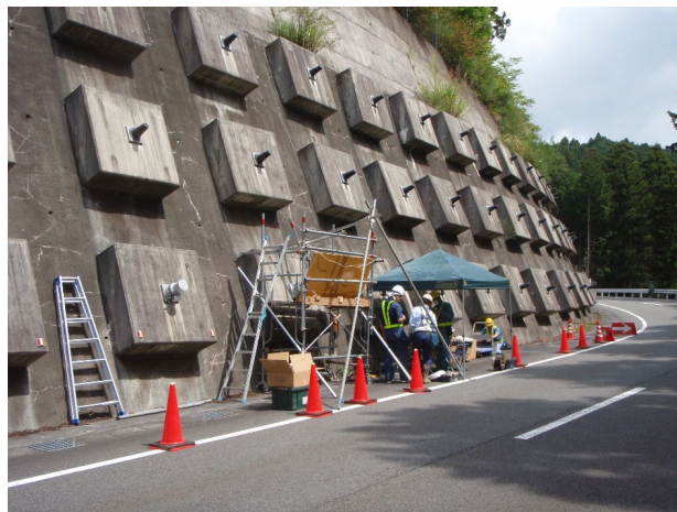
施工後に設置
