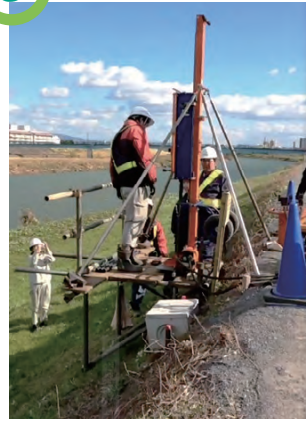
先端コーンおよび保孔管の打撃貫入
