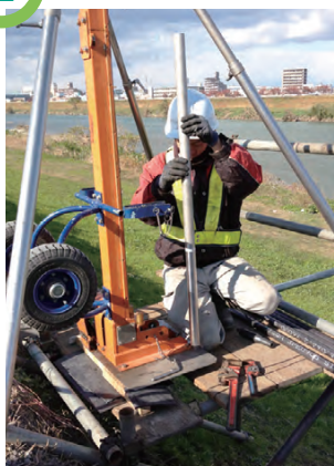
打ち込み式水位観測井の先端コーンおよび保孔管を設置地点にセット
