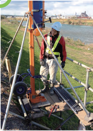
仮設足場の設置および簡易打撃装置（オートマチックラムサ운드）の設置
