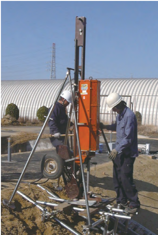
打ち込み式水位観測井の設置状況
