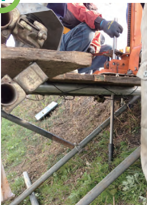
打ち込み用ロッドを保孔管内に挿入
