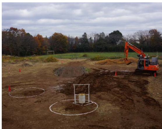
Fig. B-5 実験フィールド全景
