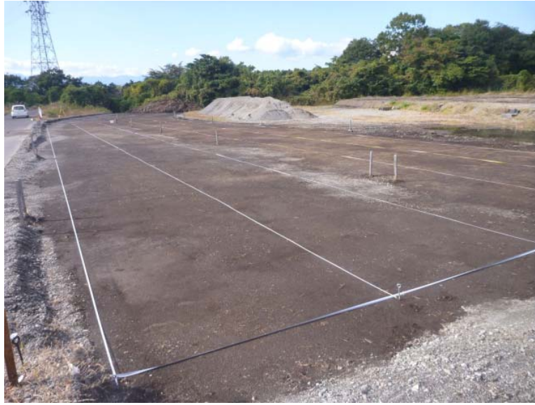
図-2.2-2 基礎地盤（路床）整地状況（始点側より）
