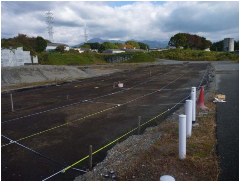
図-2.2-3 基礎地盤（路床）整地状況（終点側より）
