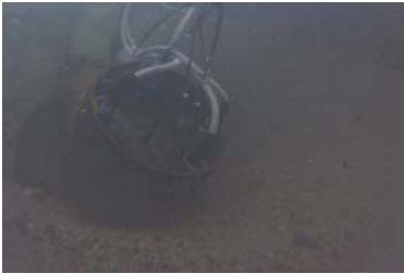
吸引部の土砂吸引の状況(水中)
