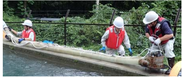
管径100mm潜行吸引式排砂管
