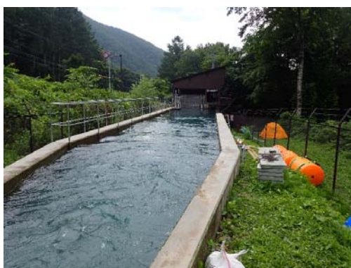
水槽兼沈砂池(運用中)
