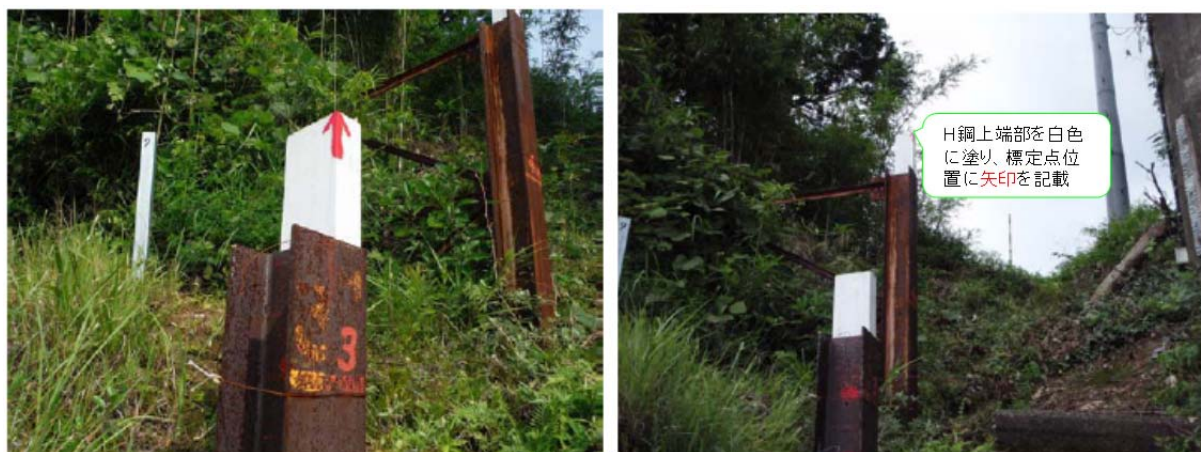
既設構造物(H鋼上流端部)を白色にしかつ矢印を書くことで標定点の視認性を向上した事例
