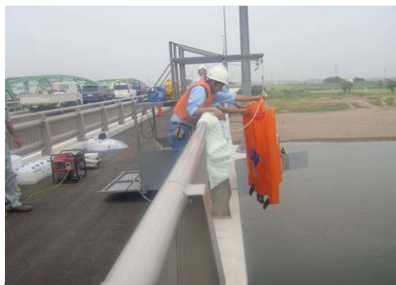
橋上操作艇の着水作業
