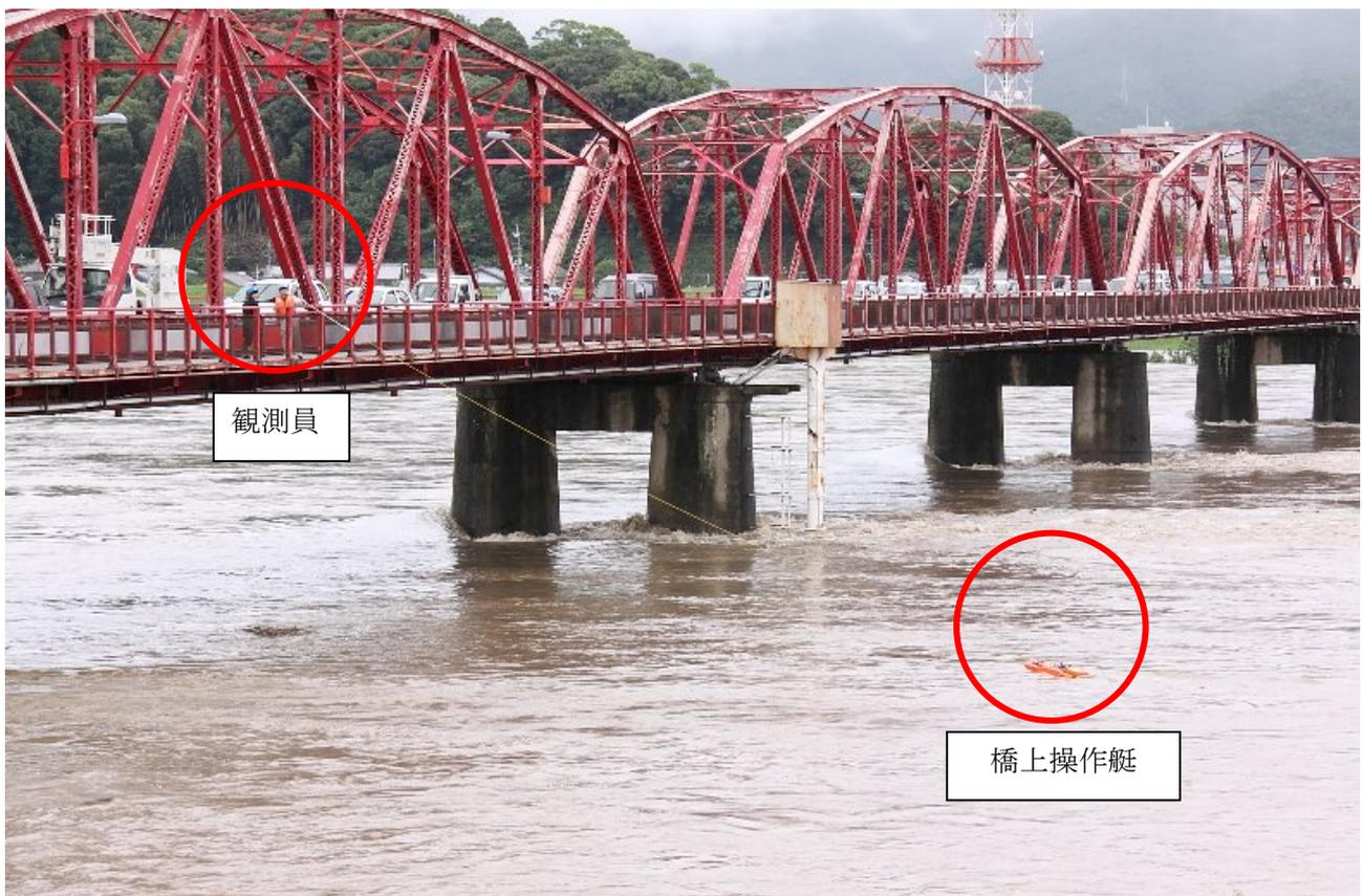
図 2-14 橋上操作艇の観測風景
