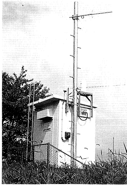
写真6・2・1 雨量テレメータ観測所の例
