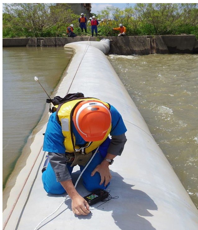
空気圧で倒伏できるゴム堰の補修調査
