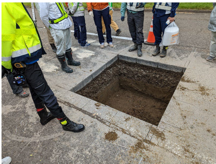
供用中の道路を開削し、劣化のメカニズムを検証
