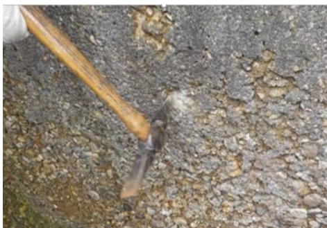
Figure1:硫酸による腐食例
